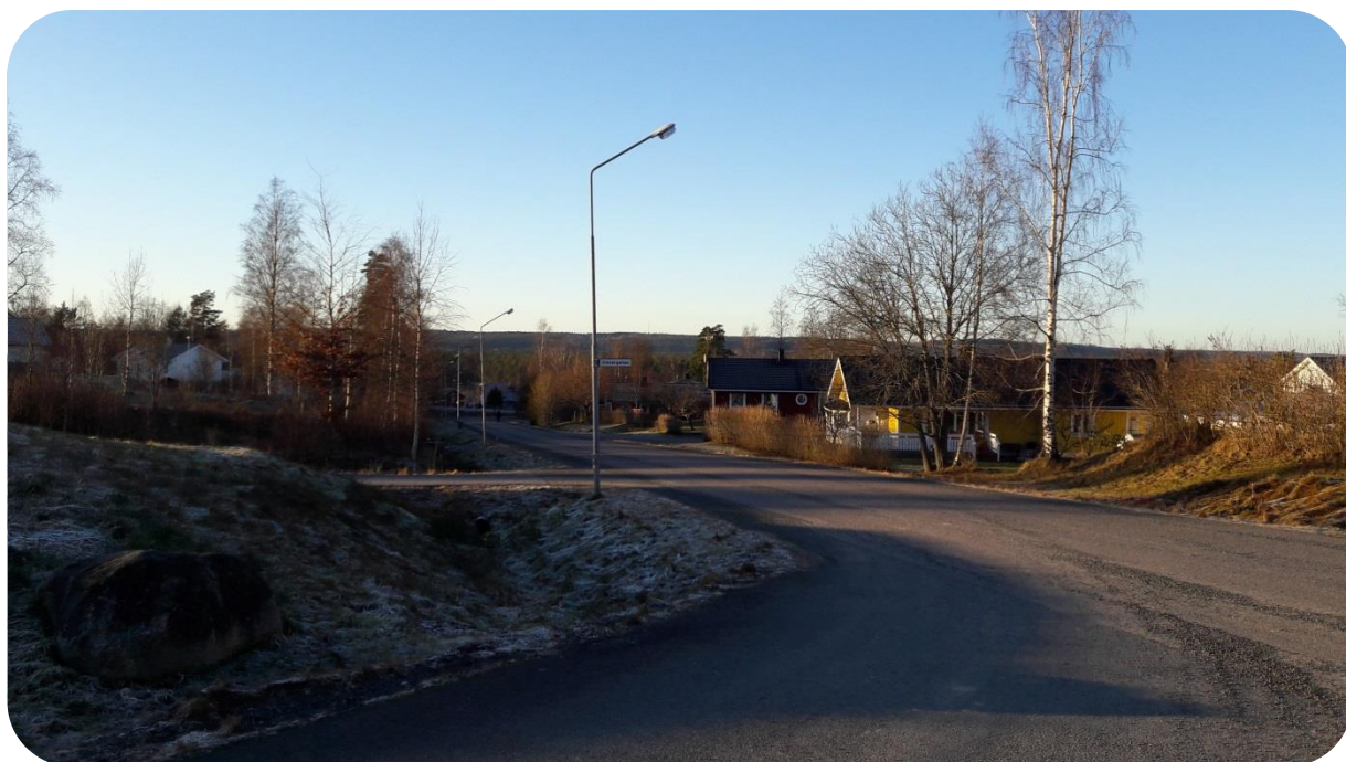
Gång- och cykelvägsutfart från Saturnusvägen till vänster i bild.
